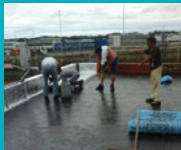
En el mes de febrero, en el mismo predio, comenzaron las reparaciones del techo del "Hostel Deportivo". Se levantó el material aislante existente y se colocó una nueva membrana. Con esto lograremos solucionar en forma definitiva las filtraciones de agua y humedad que existían. De esta manera la Regional asegurará brindarle al Asociado que se aloja en nuestro predio un mejor servicio.
