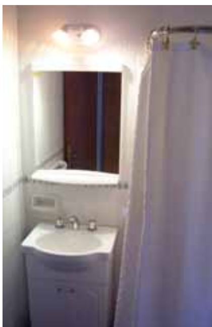
Remodelación baños Sede Central
