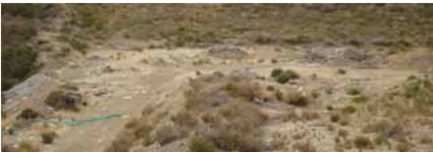
TERRENO CEDIDO POR MUNICIPIO DE COMOD. RIVADAVIA PARA LA CONSTRUCCIÓN DE VIVIENDAS
