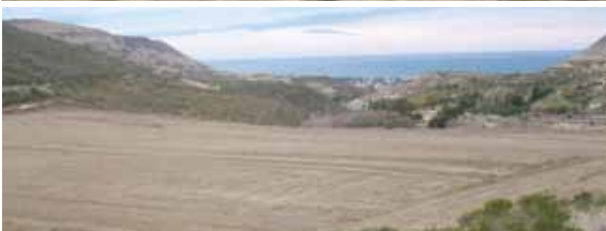
TERRENO NIVELADO PARA EL PROYECTO DE VIVIENDAS
